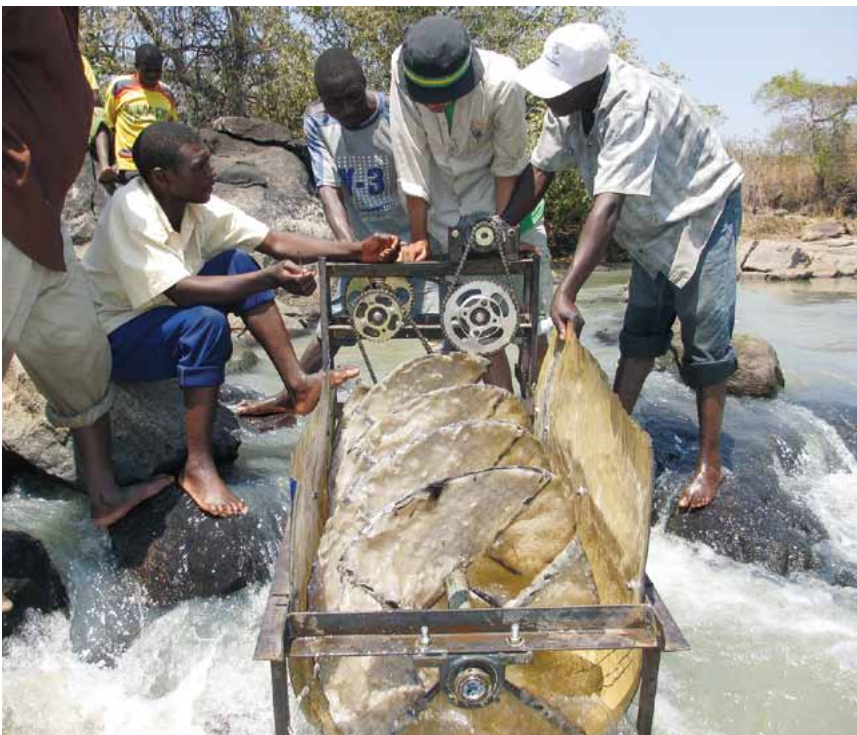
調査地の川に設置した「らせん水車」。らせん水車は大正時代に富山県で開発された技術で、緩傾斜でも発電することができる。
